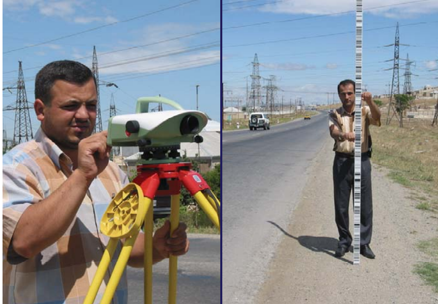
Şəkil 22.17. Rəqəmli nivelir vasitəsilə çöl çəkiliş işlərinin yerinə yetirilməsi
