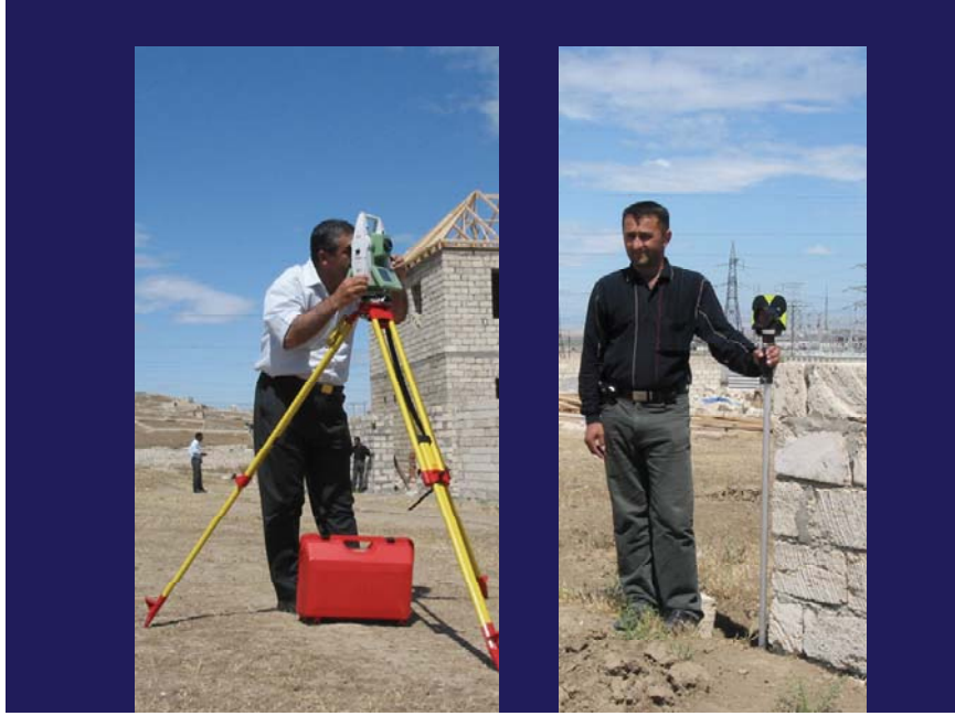
Şəkil 22.16. Total station vasitəsilə çöl çəkiliş işlərinin yerinə yetirilməsi.
